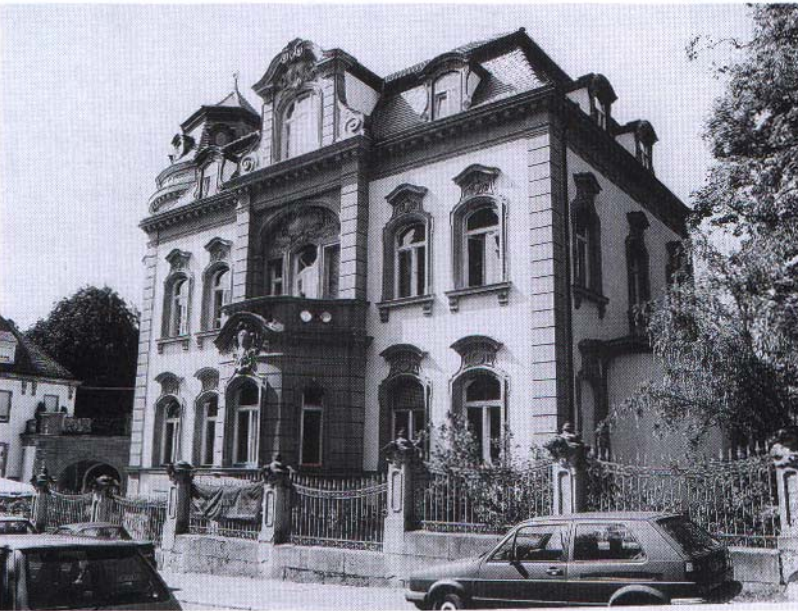
Die Fassade an der Frommannstraße
