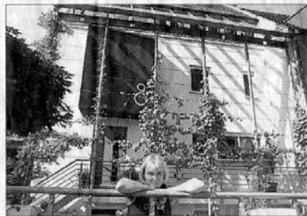
Die Vorderseite des Hauses in Gleißhammer: An den Stahlpfeilern wachsen Kletterpflanzen hoch.
