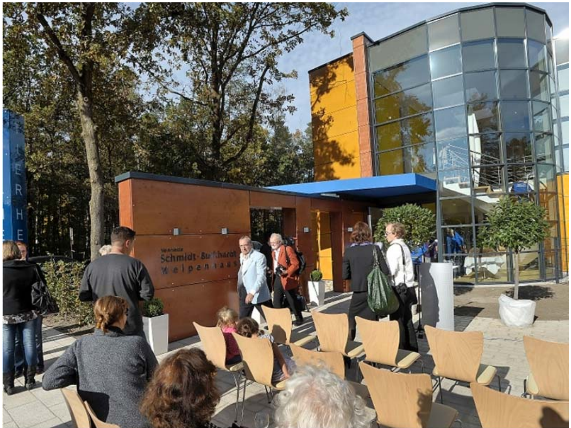
Nach zweijähriger Bauzeit konnte am Samstag endlich die feierliche Einweihung des farbenfrohen „Henriette Schmidt-Burkhardt Welpenhauses“ stattfinden.
