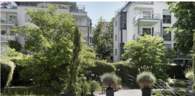
Blick vom Park auf die auf die Penthäuser
