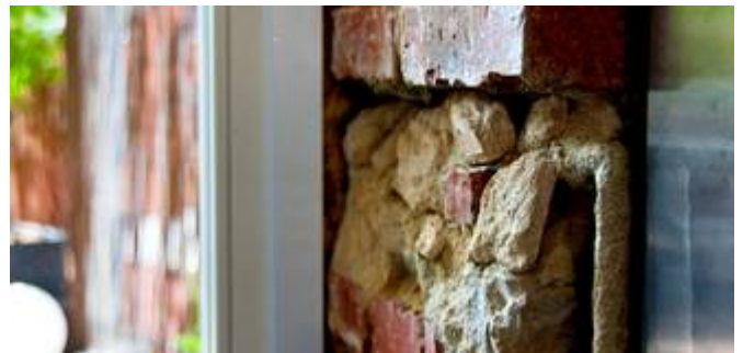
Fensteranschluss an Sicht-Stein-Wand
