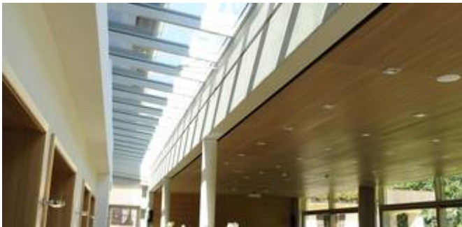
Modernisierung - Glasfuge zwischen Alt und Neu
