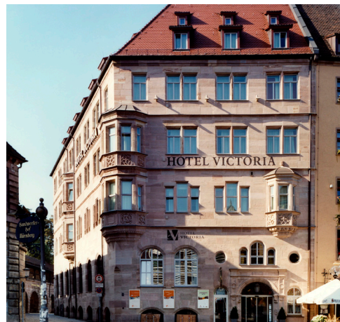
Im laufenden Betrieb wurde die historische Architektur des inhabergeführten Hotels Victoria in Nürnberg wieder sichtbar gemacht.
