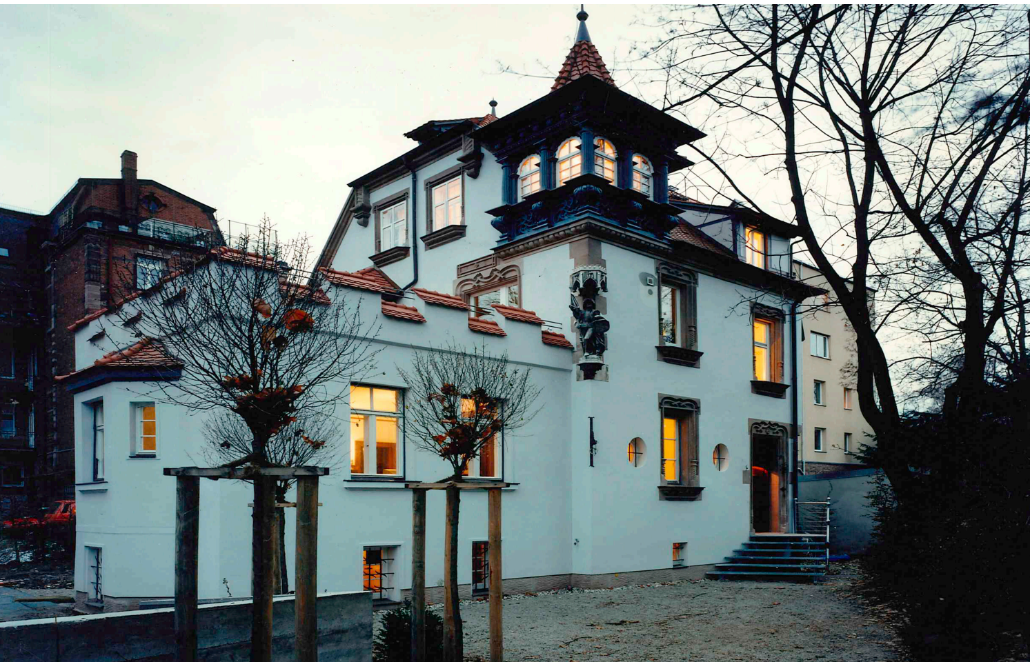
Ein erstes Projekt von Mathias Kreibich war die behutsame Sanierung, Modernisierung und Umgestaltung dieser historischen Nürnberger Stadtvilla.
