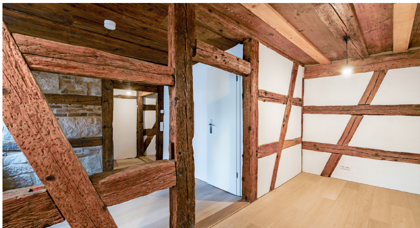
Erhalt wertvollen Kulturgutes im mittelfränkischen Raum: Sanierung inklusive Umbau und Modernisierung dreier Wohnhäuser aus dem 18. Jahrhundert.
