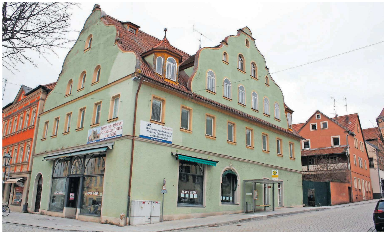
Das denkmalgeschützte Gebäude im Herzen von Gunzenhausen wurde von einem Bau-Altersforscher gründlich untersucht. Dabei stellte sich heraus, dass es bereits 1620 entstanden ist.
