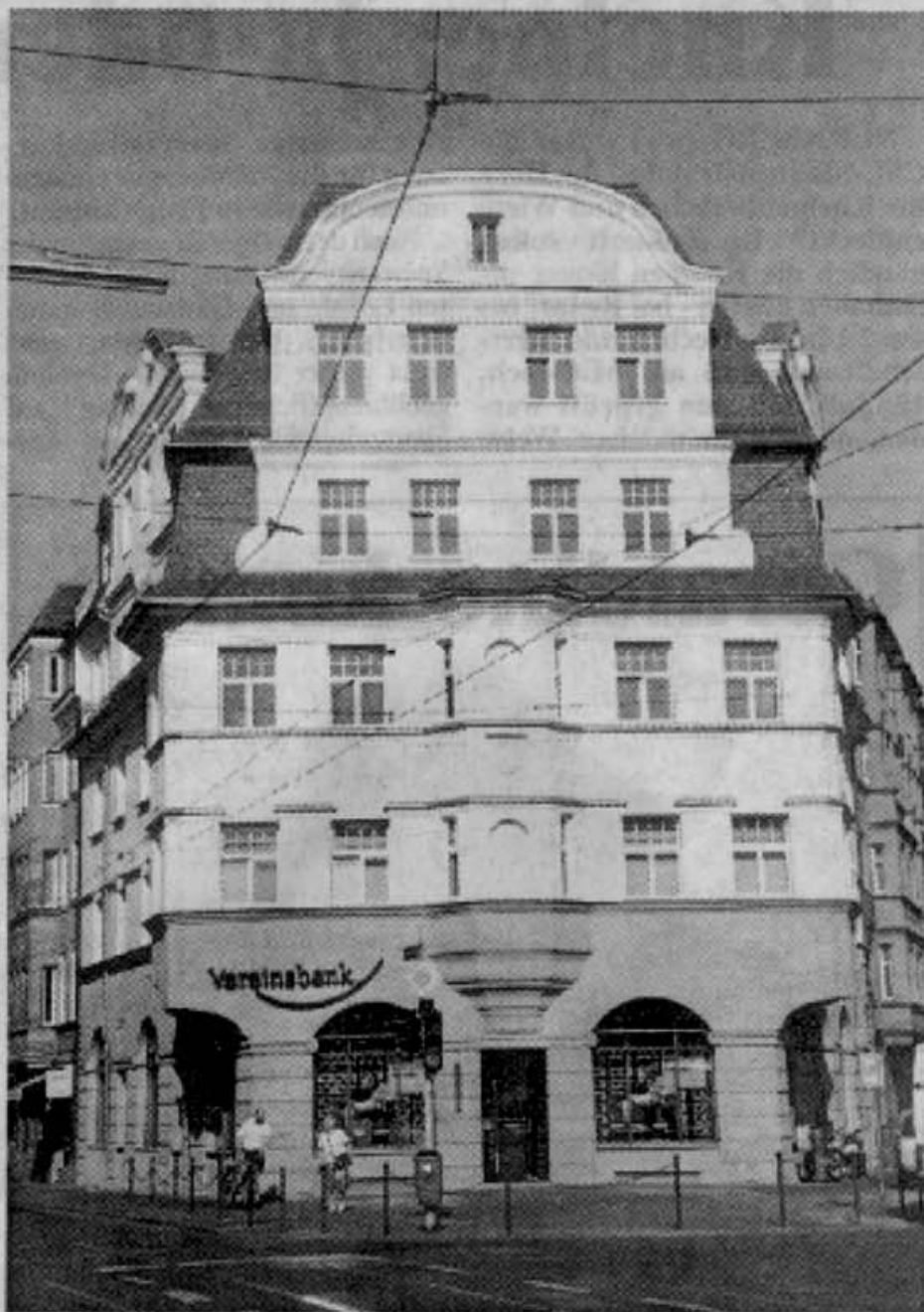
Als beispielhaft für das ganze Viertel wurde die Fassade dieses Hauses am Friedrich-Ebert-Platz gewertet. Das Haus entstand bereits im Jahre 1915. Fotos: Bischof + Broel KG
